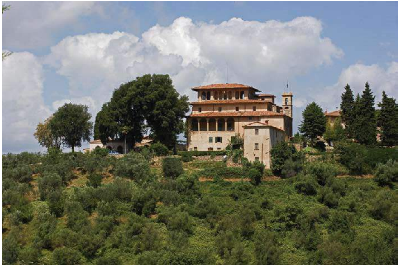
Il prospetto laterale con il loggiato “rinascimentale” del piano nobile
