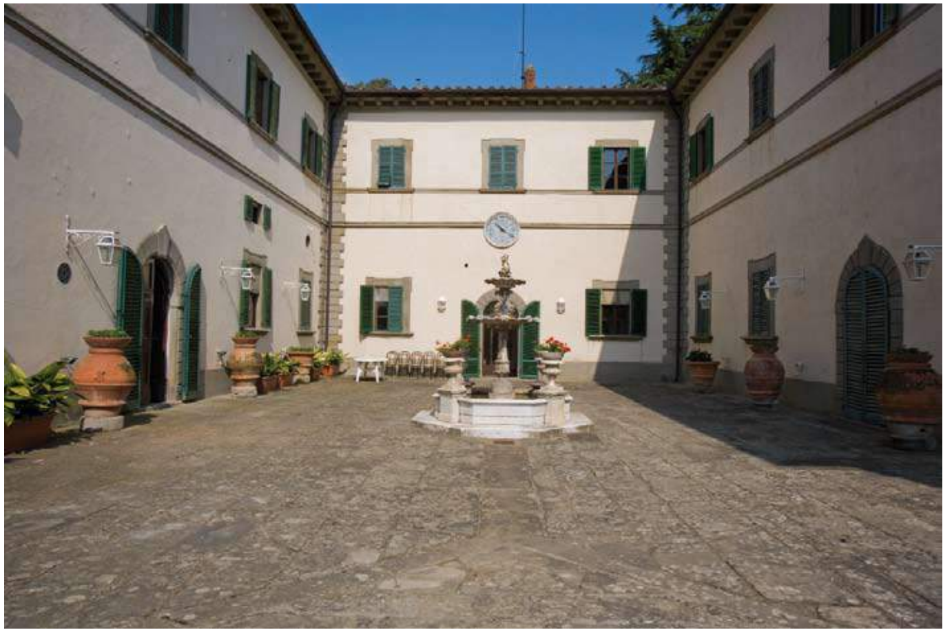
Piazzale lastricato delimitato dai corpi di fabbrica della villa con al centro una fontana marmorea
