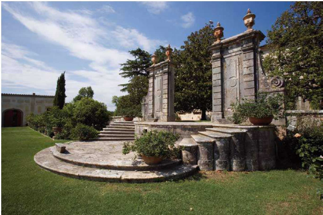
Scalinata che dal piano della villa immette nel giardino à parterres
