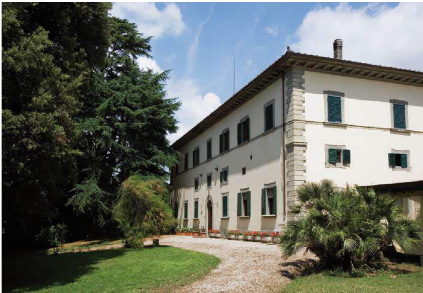
Prospetti di sud-ovest della villa sui quali si evidenziano i mezzanini
