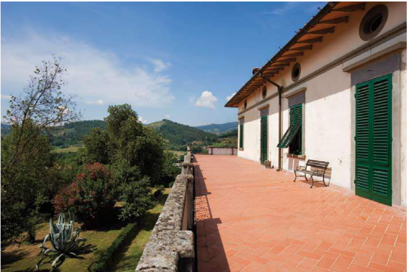
Veduta del terrazzo del primo piano della villa sul fronte settentrionale
