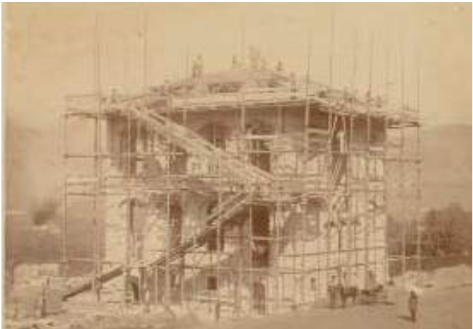
Il cantiere di villa Martini in una foto d’epoca (BNCF, Fondo Spighi , n. 23.14)
