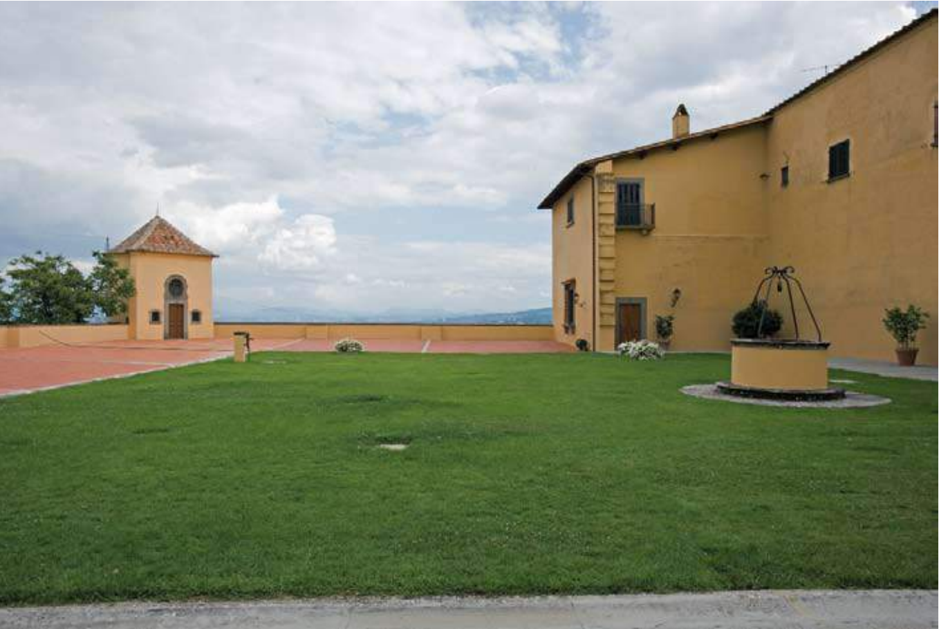
Veduta del torrione dell'angolo di nord-est e della corte interna
