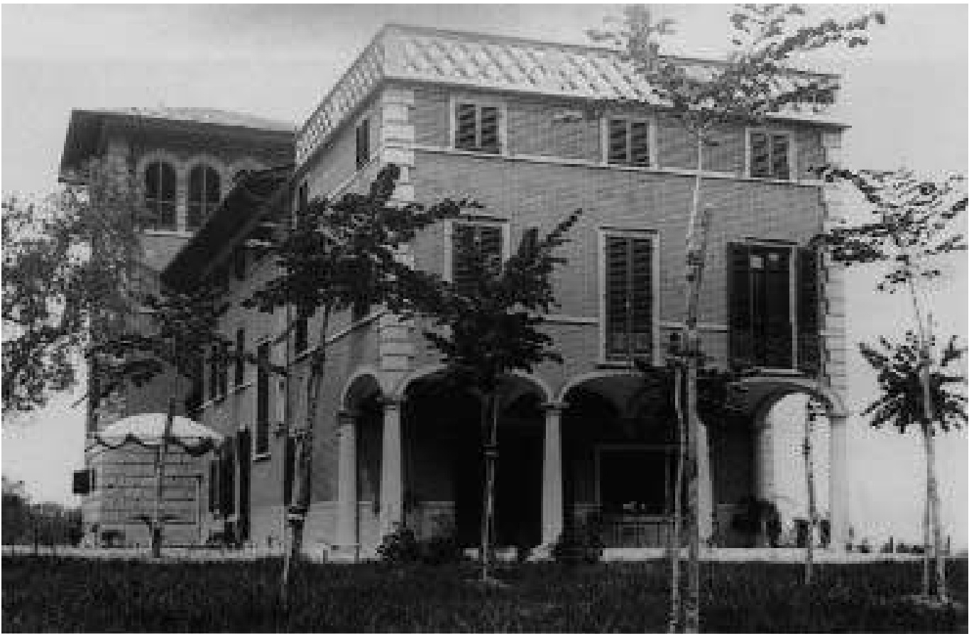
Veduta di villa Spalletti dopo le ristrutturazioni apportate all'immobile dal conte Venceslao II negli ultimi anni dell'Ottocento
