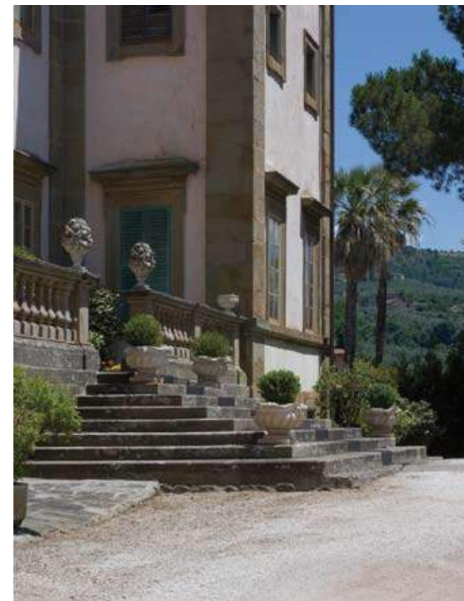
Accesso al piano terreno rialzato
