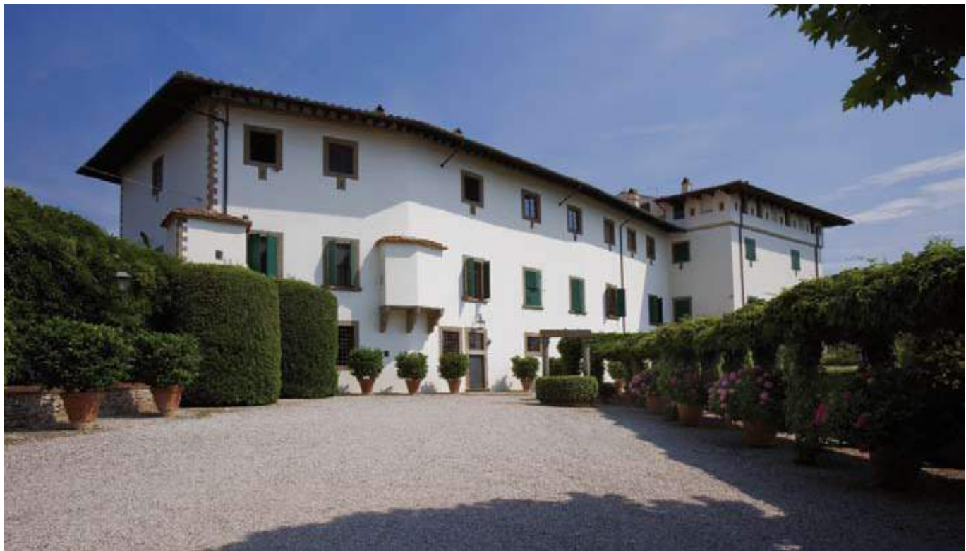
La villa di Montevettolini, prospetto sul giardino
