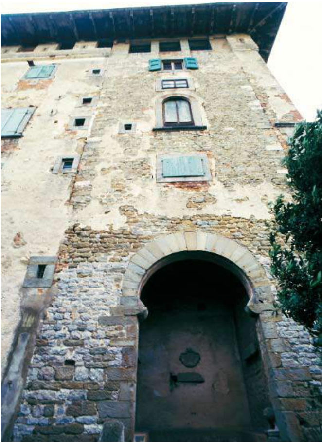
La porta del Cantone incorporata nella villa in una veduta prima del recente restauro
