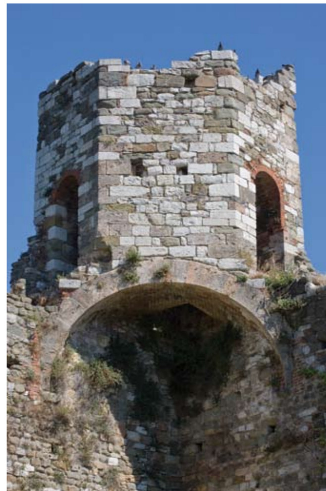
In alto, sinistra, rocca nuova, torretta pensile a base pentagonale. L'apparecchio murario molto curato utilizza la pietra arenaria e calcarea e, per pochi elementi, il laterizio; a destra, rocca nuova, torretta pensile a base pentagonale. L'apertura che consentiva l'accesso diretto dalle mura presenta un arco a pieno centro realizzato in laterizio
