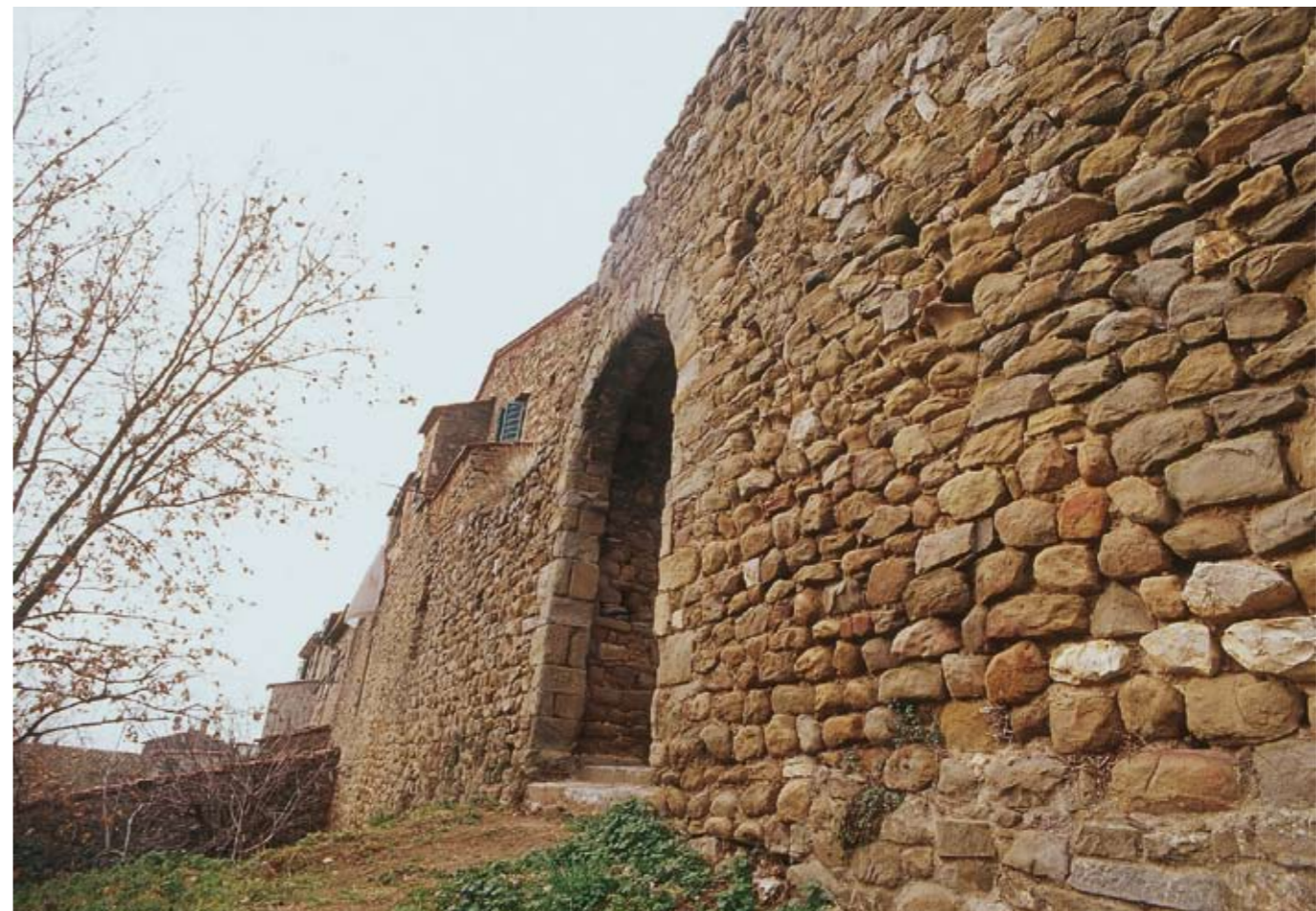
Cortina muraria e porta sul lato est
