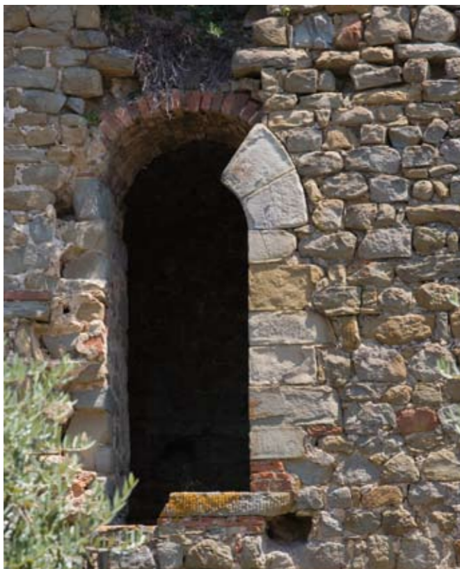
Sopra e a destra, torre “del Vitoni”, particolare. Conci irregolari contornano la monofora aperta nella tessitura muraria in sassi appena rifiniti
