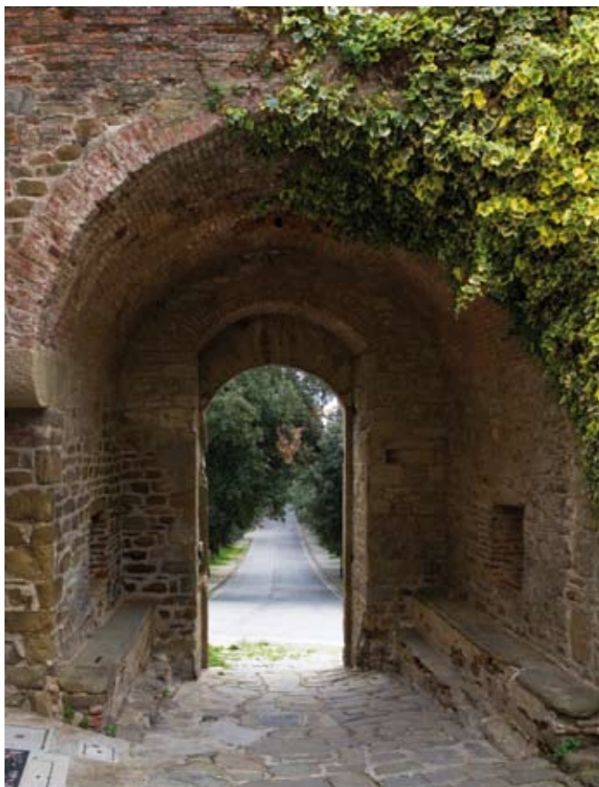
Porta, verosimilmente detta la «Fiorentina», veduta interna. L'arco ribassato delimita l'ampia volta a botte ricavata nello spessore murario
