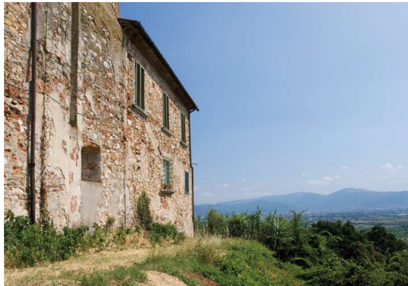
Annessi alla chiesa di San Bartolomeo, particolare della parte tergale
