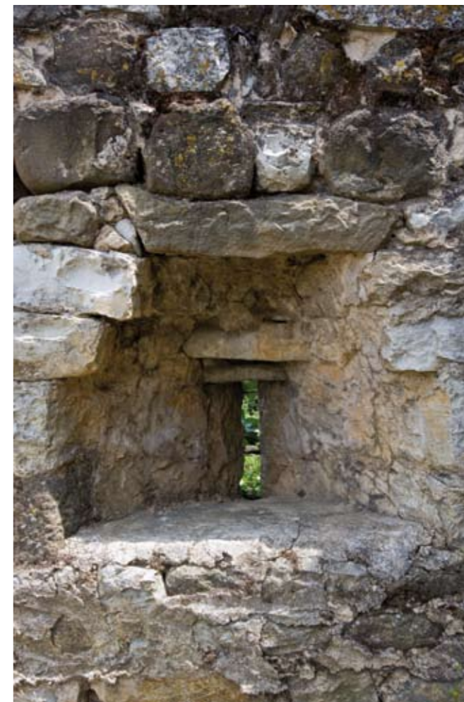
Rocca nuova, feritoia ricavata nello spessore murario
