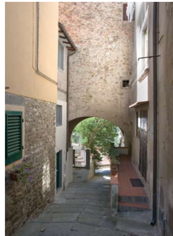
Via degli Scalini, uno dei collegamenti interni al castello caratterizzati da vicoli lastricati in pietra arenaria ed intervallati da passaggi voltati
