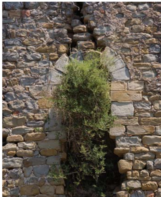
Nella pagina precedente, la torre “del Vitoni” risulta in posizione decentrata rispetto alla probabile cinta castellana di cui costituiva il mastio; la torre è realizzata in pietra e presenta aperture arcuate in corrispondenza dei piani interni
