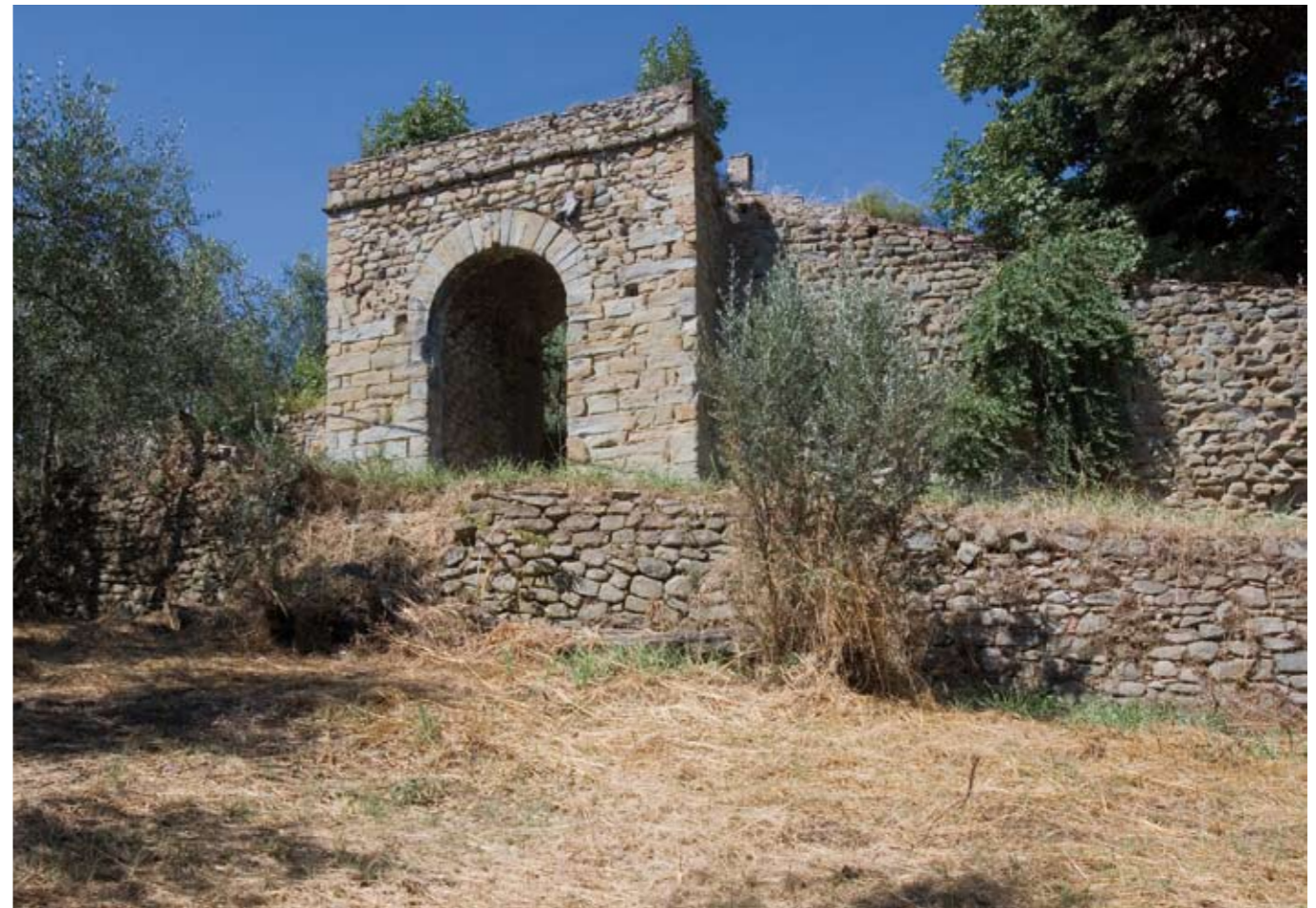
Porta sud, esterno. L'apertura ad arco a pieno centro è realizzata in conci regolari di pietra come i piedritti
