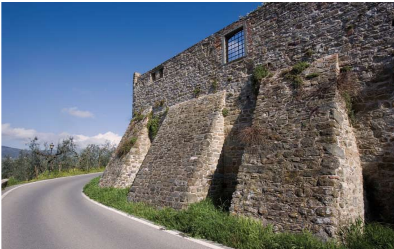
Tratto della cortina muraria in blocchi di arenaria in prossimità della porta meridionale di accesso al castello verosimilmente detta di «Santa Maria»
