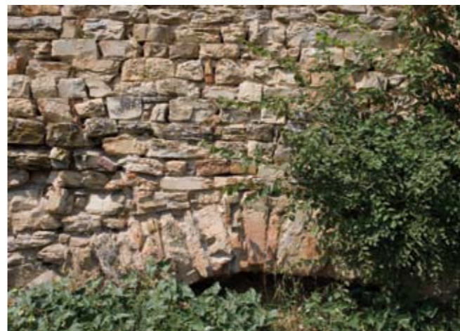
Particolare dell'apparecchiatura muraria delle cortine
