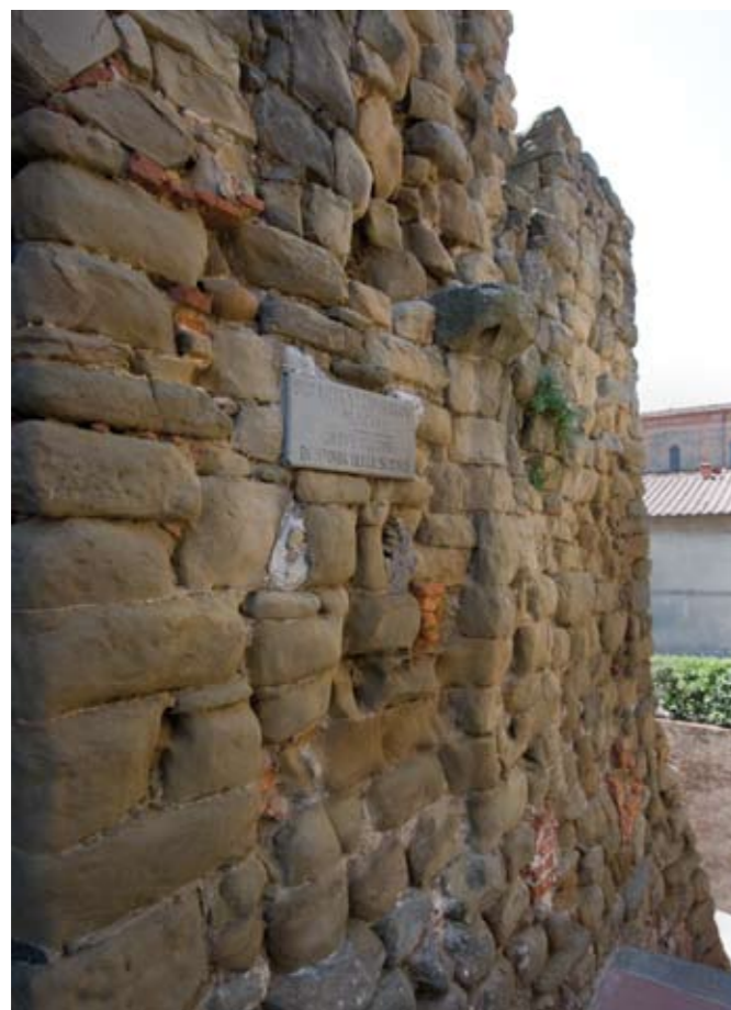
In alto a sinistra, feritoie arciere; a destra, particolari dell'apparecchiatura muraria della parte basamentale del castello (arco di scarico); in basso, a sinistra e a destra, la cortina muraria in blocchi di arenaria in prossimità della porta di accesso del castello
