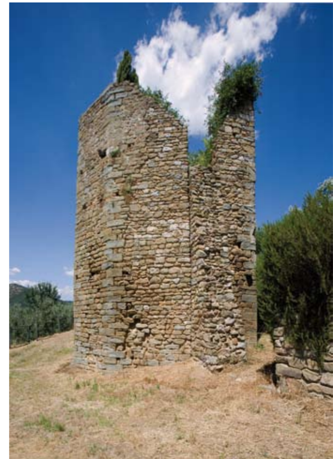
Montevettolini, la torre poligonale di irrobustimento del circuito murario più esterno ("la murina")
