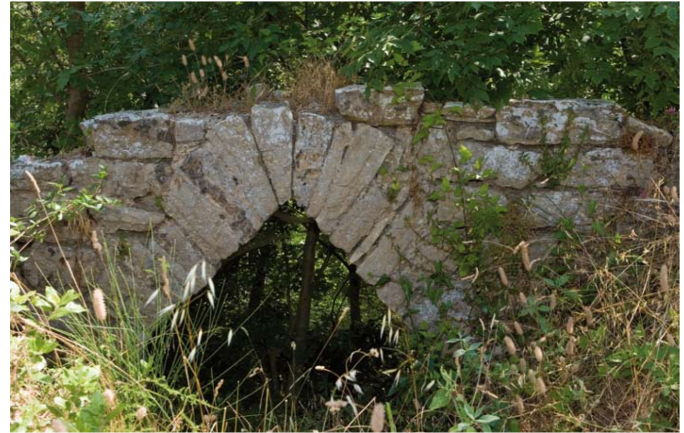
Una probabile feritoia aperta nella cinta muraria realizzata in pietra a blocchi piuttosto irregolari
