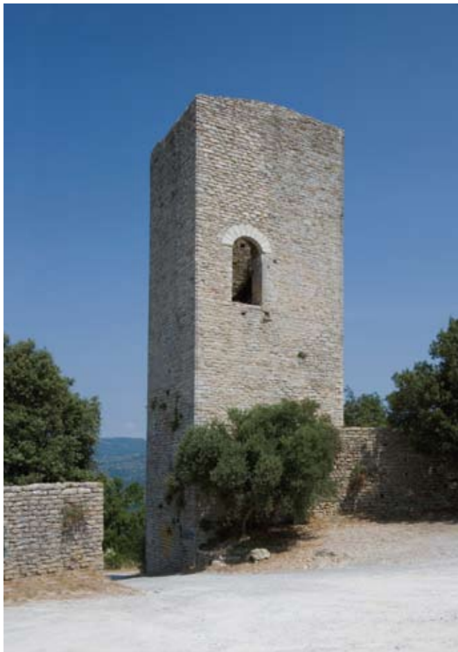
Torre pentagonale di Monsummano castello. La porta d'accesso sopraelevata e la quasi totale assenza di aperture testimoniano della funzione difensiva della struttura
