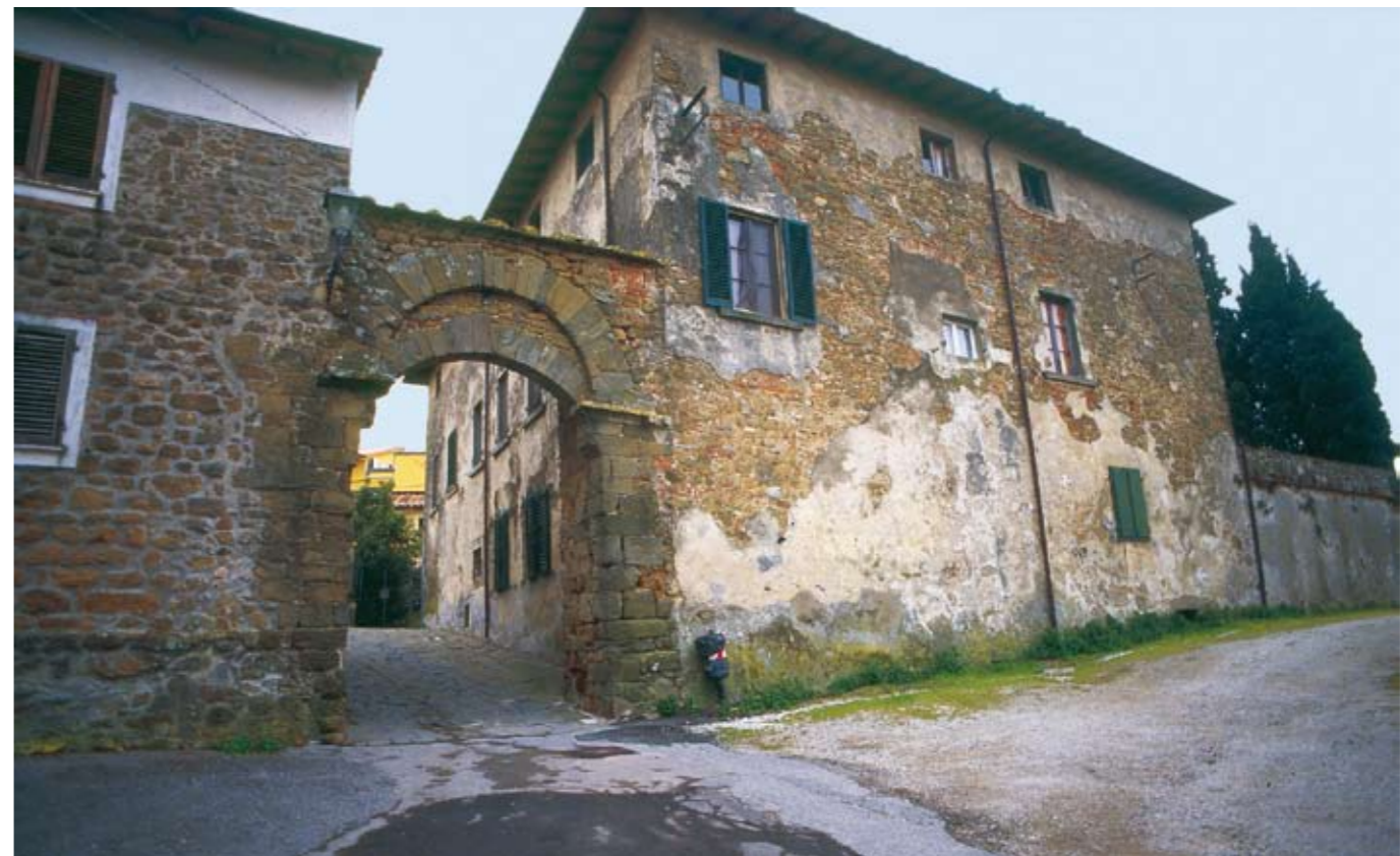
Porta Barbacci o del Vicino, esterno; l'apertura presenta la caratteristica soluzione che combina l'arco ribassato con l'arco a pieno centro secondo modelli di riferimento di ambito fiorentino
