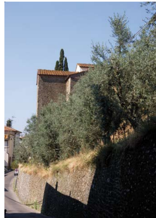
Il circuito murario utilizzava il ripido versante collinare (lato est) e ne seguiva l'andamento
