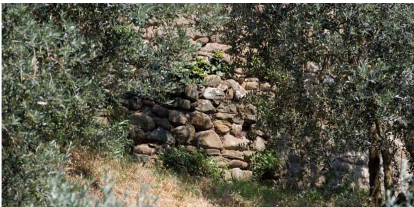
Possibili tracce dell'apparecchio murario medievale (lato est) in conci di arenaria disposti a filari regolari
