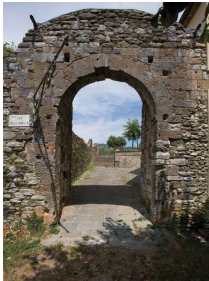
Porta della Gabella, esterno. La porta si apre in prossimità della Rocca nuova e presenta un'accurata finitura dell'arco a pieno centro realizzato in conci regolari di pietra arenaria
