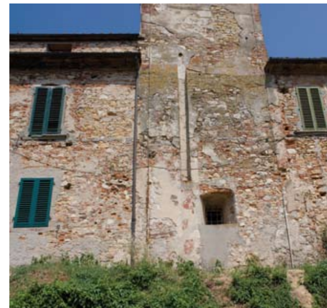
Campanile e canonica della pieve di San Bartolomeo, particolare della parte tergale e dell'apparecchiatura muraria
