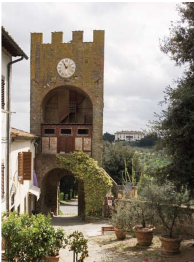
Porta, verosimilmente detta la «Fiorentina», veduta interna. Su questo lato la torre mostra un ampio arcone nel quale sono stati ricavati ballatoi lignei (di ripristino)
