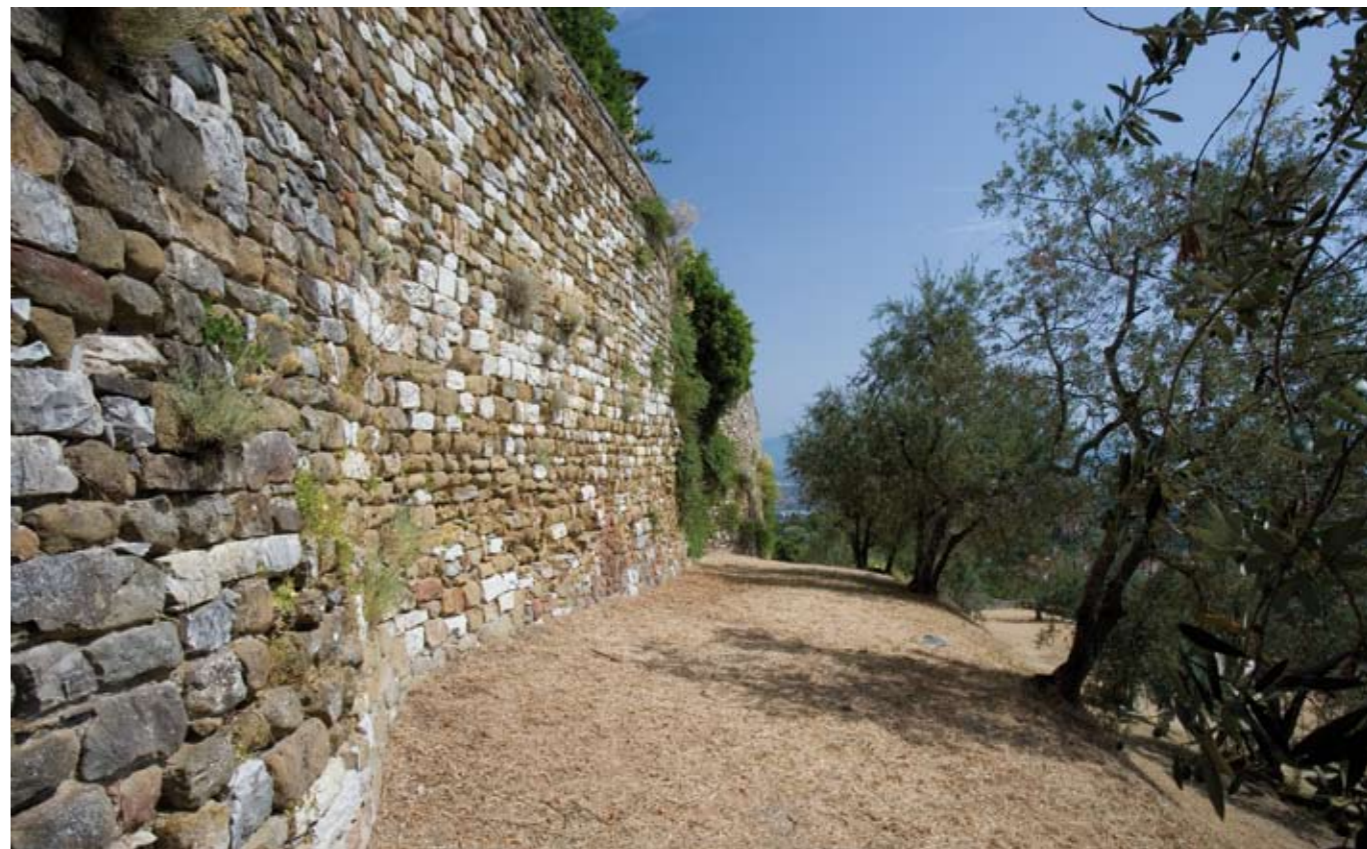
Tratto della seconda cortina muraria in blocchi di arenaria e alberese in prossimità della porta di accesso del castello detta «Santo Ginepro», oggi sostituita da un cancello
