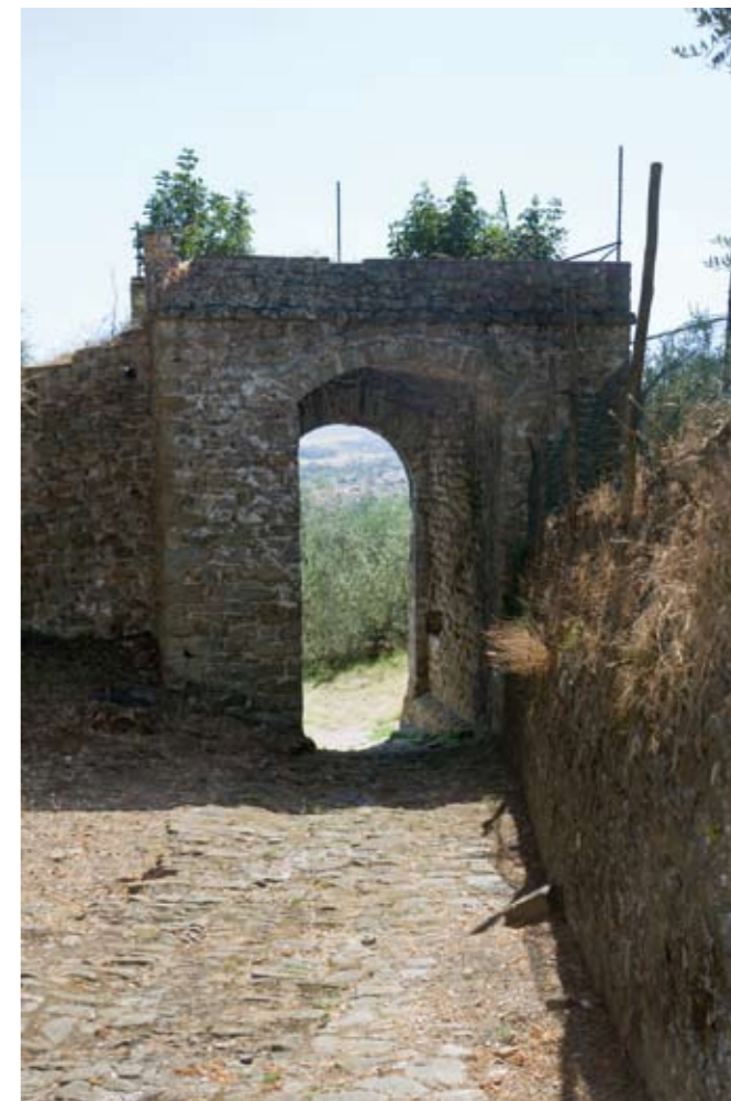
Porta sud, fronte interno. La porta risulta più tarda delle altre e doveva essere munita di torre corredata di bertesche
