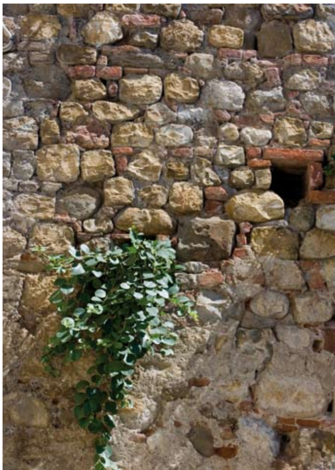
Particolare dell'apparecchiatura muraria delle cortine
