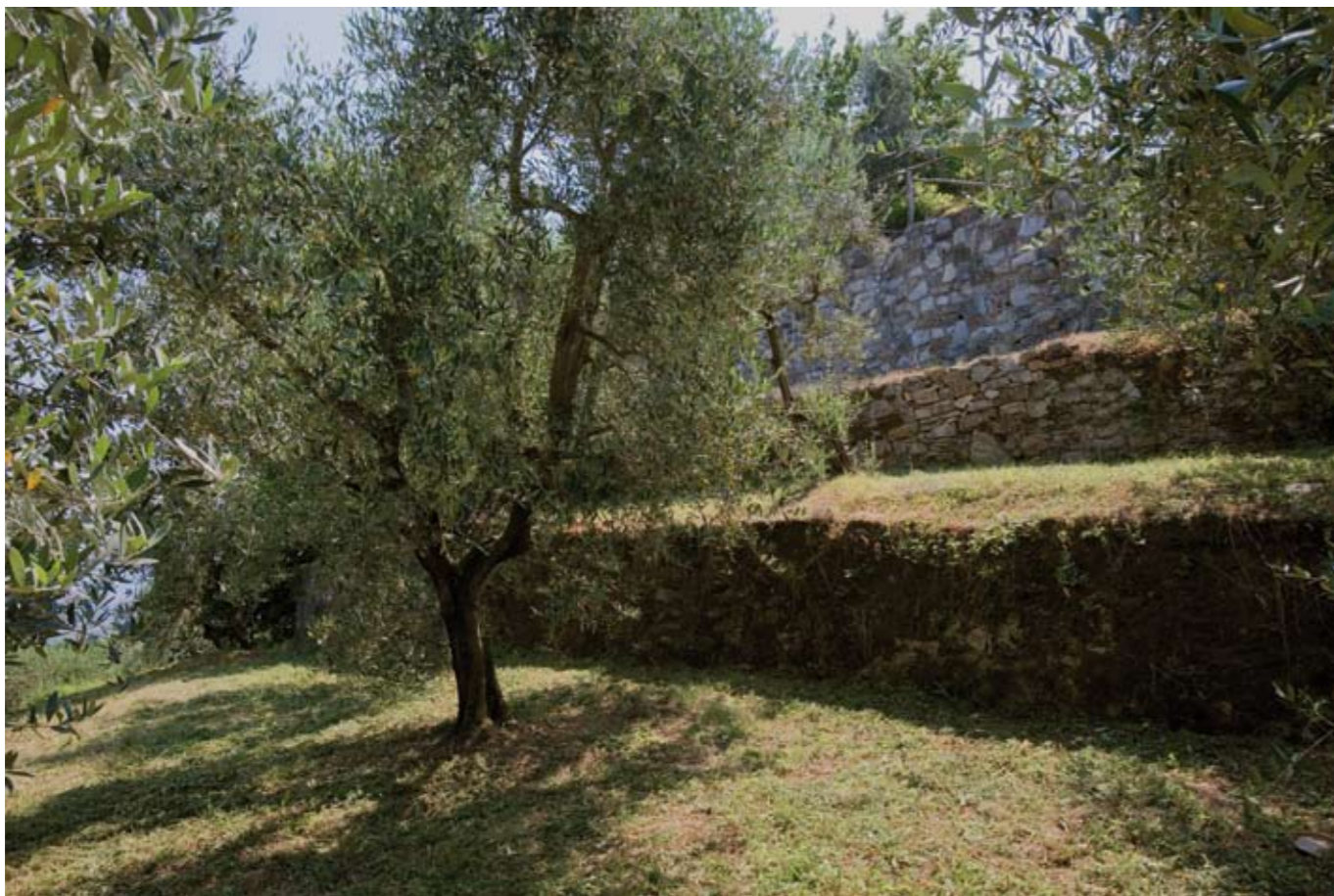
Tratto di mura castellane nella porzione occidentale
