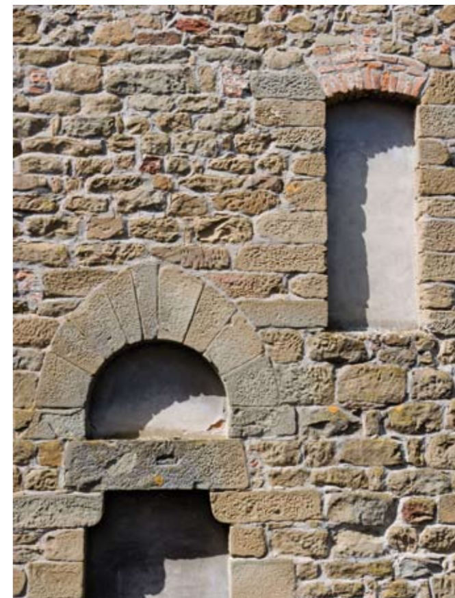
Particolare della torre saxezzata (nei pressi del n. 57 di via Cinque Martiri), in evidenza un'apertura dotata di archivolto a sesto acuto e architrave su mensole convesse e una finestra di forma rettangolare
