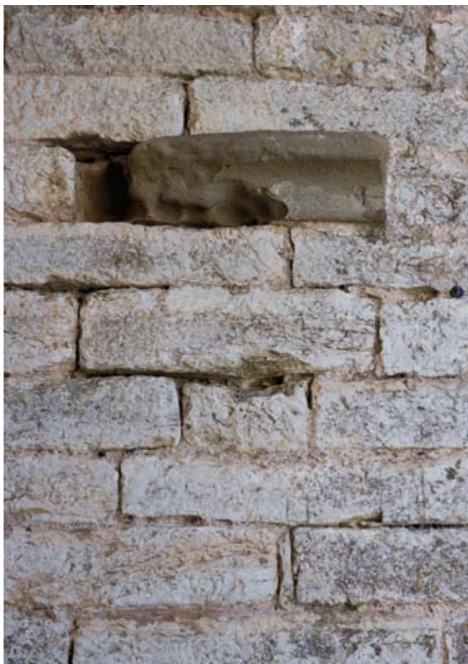
Torre pentagonale, dettaglio dell'apparecchio murario a conci regolari ben connessi
