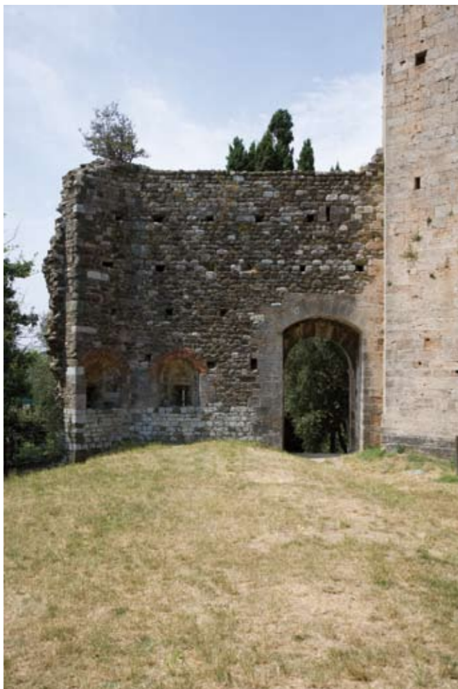
Rocca nuova. La porta aperta alla base della torre esagonale fa parte di un intervento successivo
