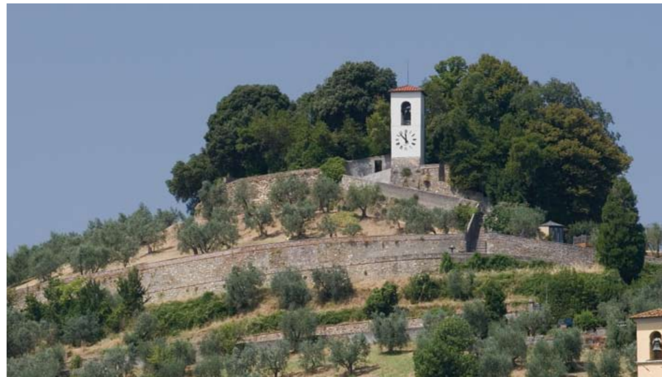
Carmignano, la torre della rocca dominante sulla pianura e sull'abitato castellano
