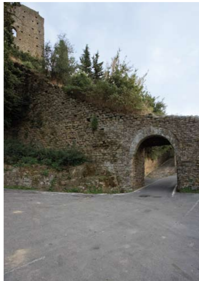
La porta nord-ovest, esterno. L'arco a pieno centro realizzato in conci di pietra presenta l'estradosso ad arco crescente; conci di pietra ben rifiniti caratterizzano i piedritti
