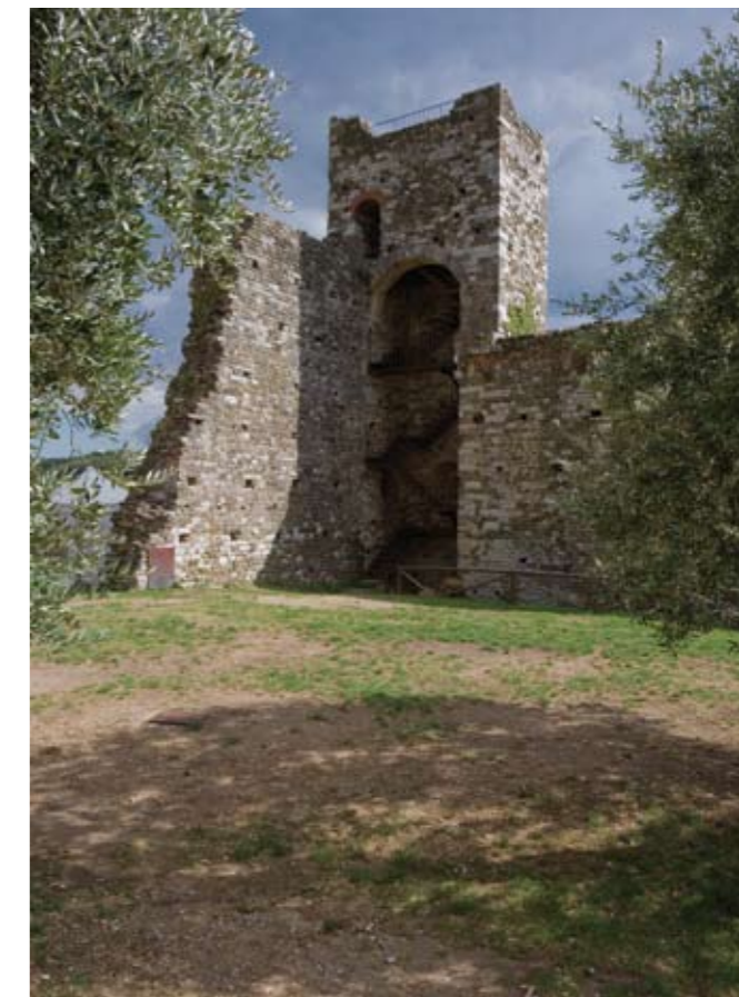
Rocca nuova, torre angolare a base quadrata. La grande apertura della muratura consentiva l'accesso alle mura degli armati
