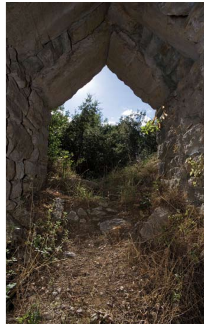
Sopra e nella pagina successiva, l'apertura in blocchi speciali di pietra calcarea locale è ricavata nello spessore murario per alloggiare le sentinelle (vista interna ed esterna)
