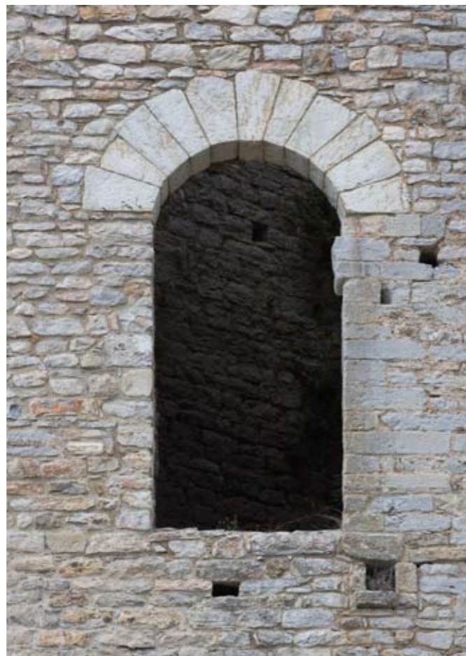
Torre pentagonale, particolare della porta aperta in quota; l'arco è realizzato in pietra calcarea locale
