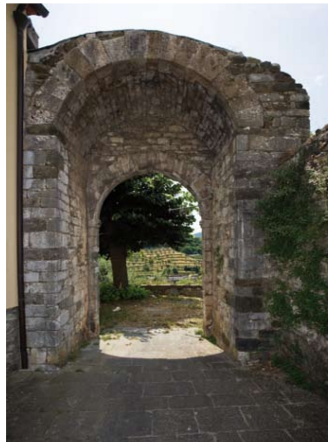
Porta della Gabella, interno. L'archivolto ricavato nello spessore murario conteneva il portone ligneo che si apriva dall'alba al tramonto
