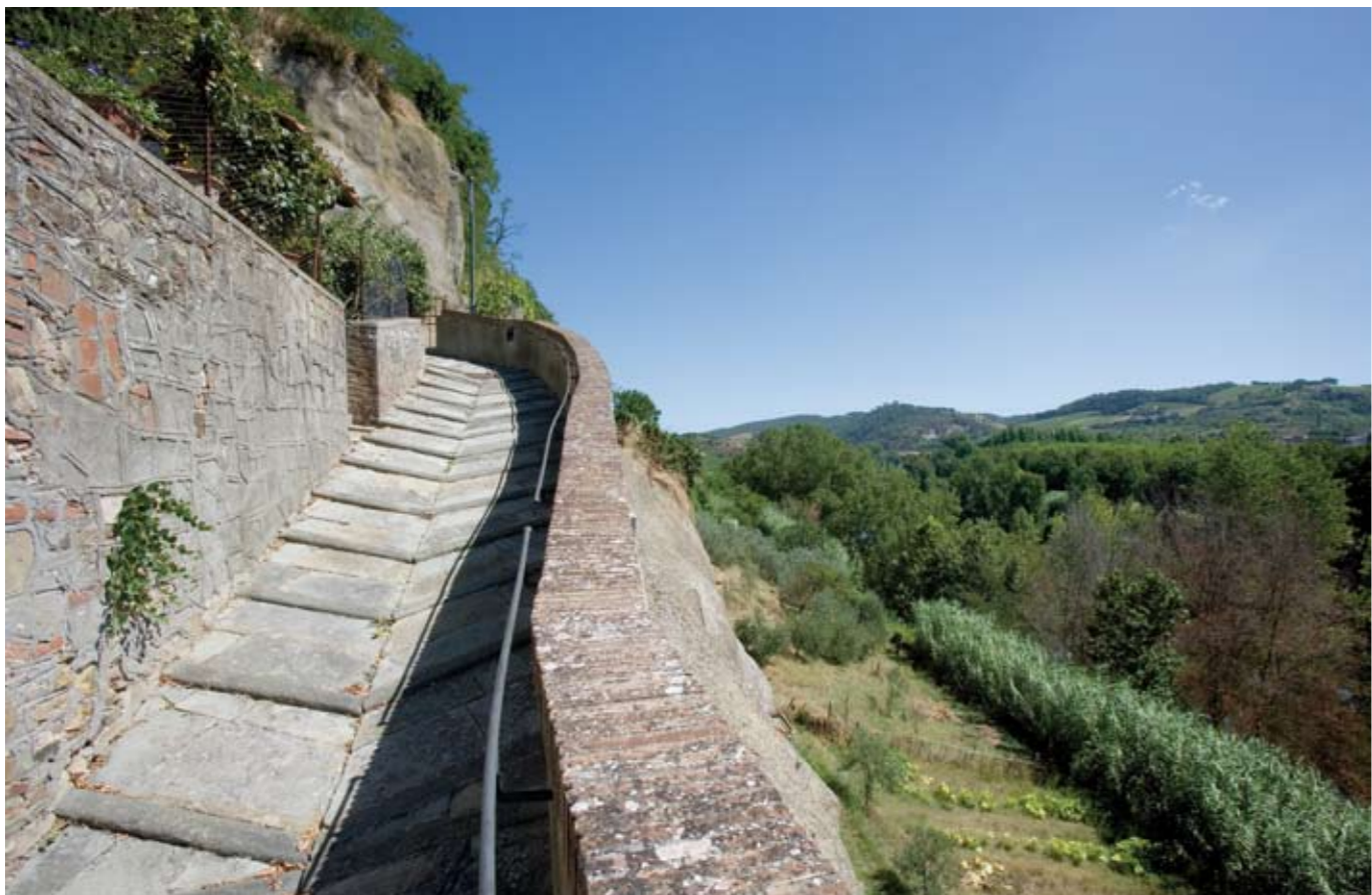
Veduta di un tratto di via degli Scalini; il selciato è costituito da lastre di pietra posate in diagonale, disposizione che nei secoli passati era preferita per facilitarne la percorrenza ai cavalli e per consentire il deflusso delle acque pluviali
