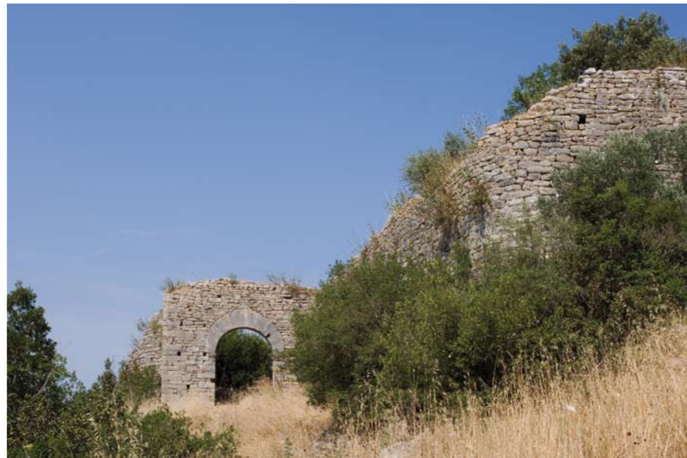
Porta del Mercato o del Pidocchio, esterno. L’apertura ad arco è realizzata in conci regolari di pietra calcarea che nell’estradosso disegnano un arco crescente
