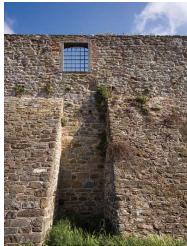
Particolare della cortina meridionale con scarpa
