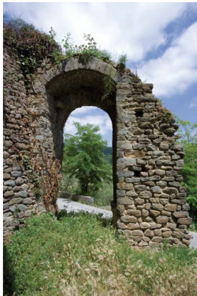
Porta nord-est, vista interna. L'arco a sesto ribassato caratterizza l'apertura della porta verso l'interno
